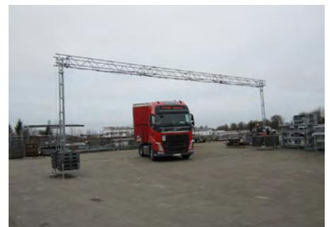
Montierte Kabelbrücke - Rapid
